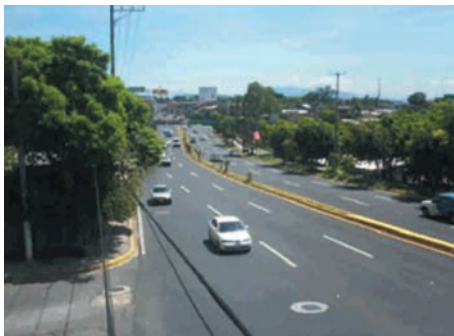
Vista panorámica de la 49 Av. Sur con nueva carpeta asfáltica colocada.
