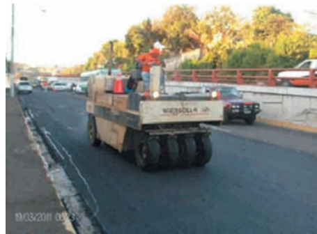
Proceso de sello de mezcla asfáltica colocada
