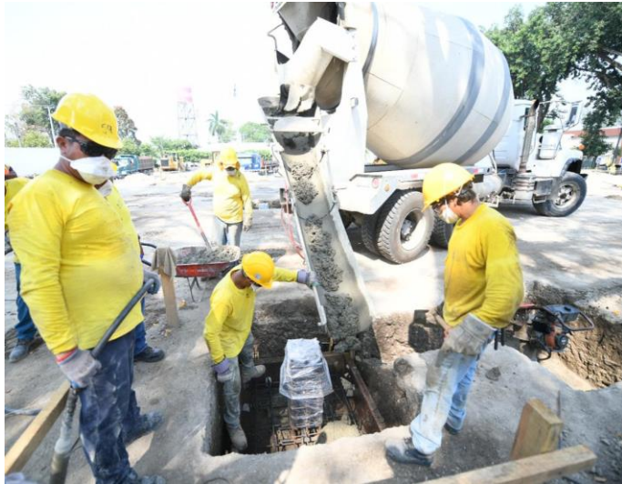
Sector de Baños del Hospital en parqueo contiguo al Pabellón Centroamericano
