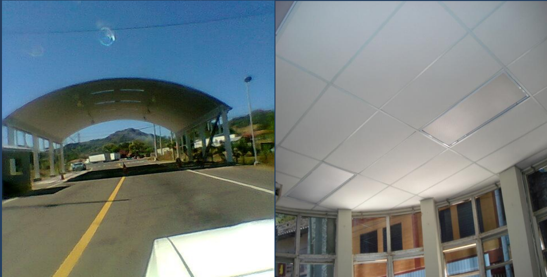
Instalaciones de aduanas recién remodeladas
